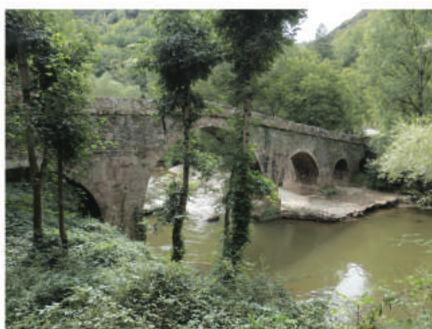
Le pont de Conques est un ouvrage d'art en maçonnerie de 5 arches en plein cintre d'une longueur totale de 41 mètres et présentant une largeur utile de 2,30 mètres. Il est construit en grès rouge et est dissymétrique. Les piles sont terminées à l'amont par des avant-becs surmontés de chaperons. Une plinthe, en cordon, couronne l'ouvrage.
