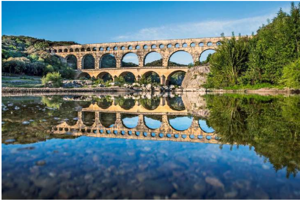
Façade aval du pont du Gard ©Richard Sprang
