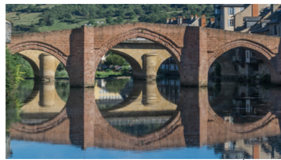
PONT VIEUX D'ESPALION
