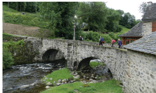
Pont de la boralde de Saint-Chély
