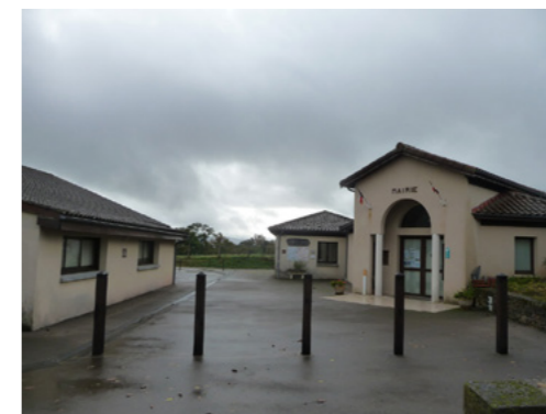
L'espace public bitumé devant la halte aménagée et abritée de Saint-Jean-Mirabel à qualifier
