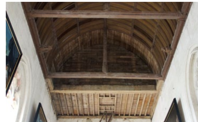
Voûte en berceau de la nef
