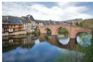
Espalion, pont sur le Lot.
