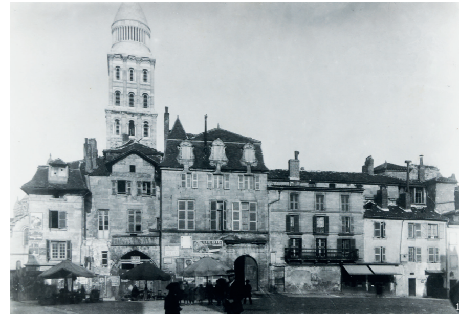
Fig. 1 : Marquis de Fayolle, Vue de la place de la Clautre et des diverses constructions venues s'accoler à la façade ouest de Saint-Front, fin du XIX e siècle © Société historique et archéologique du Périgord
