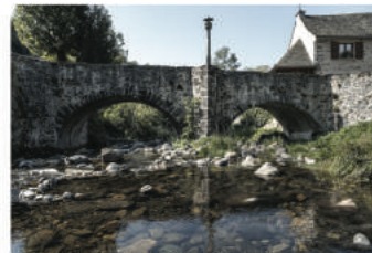
Pont des Pèlerins de Saint-Chély d'Aubrac sur la Borade
